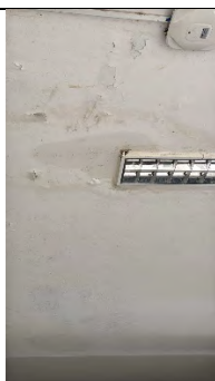
Imagens de alguns dos pontos de vazamento (em diferentes locais) da Civil
