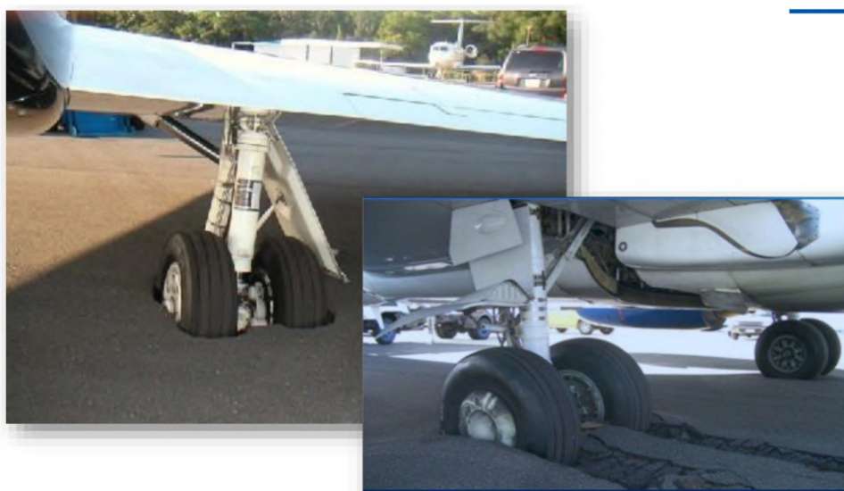
FIGURA 3.1 – Exemplo de danos estruturais em pavimentos devido a solicitações excessivas de aeronaves.
