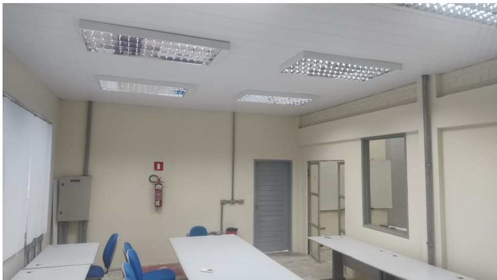
FIGURA 4.3 – Vista interna 3 da sala (Fonte: Arquivo Pessoal)
