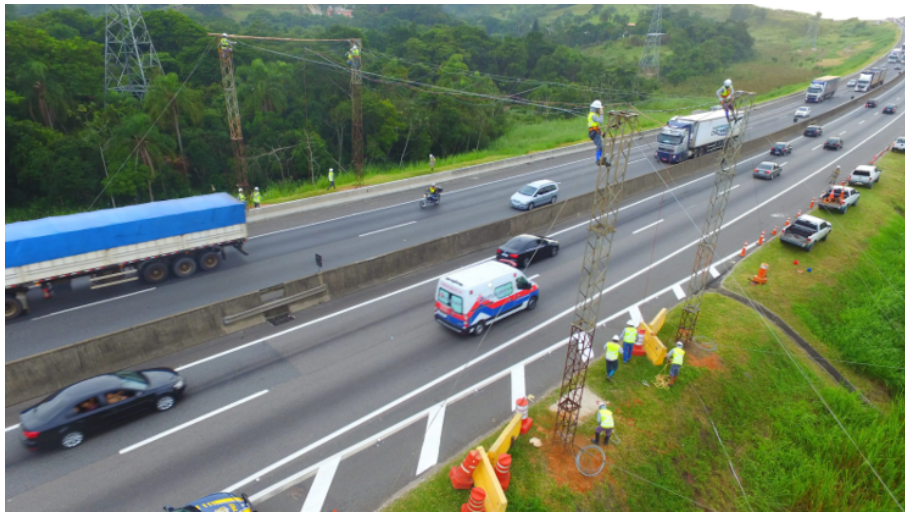
FIGURA 2.4 – Exemplo de trecho rodoviário com obstáculo de canteiro central
