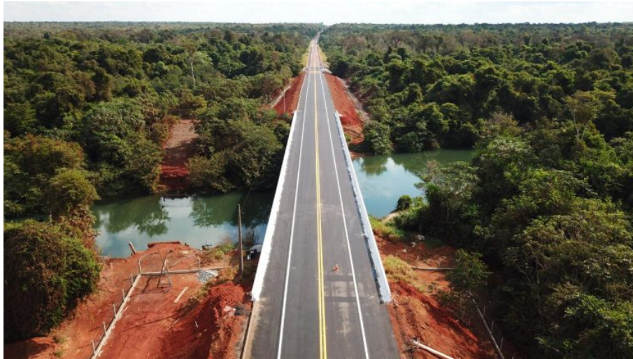
FIGURA 3.5 – Trecho rodoviário em ponte
