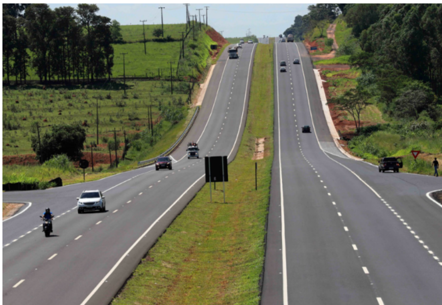
FIGURA 2.7 – Trecho da rodovia com grande declividade
