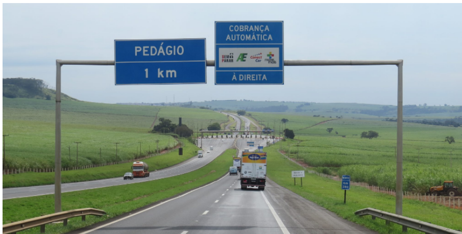
FIGURA 3.6 – Trecho de rodovia com obstáculo físico
