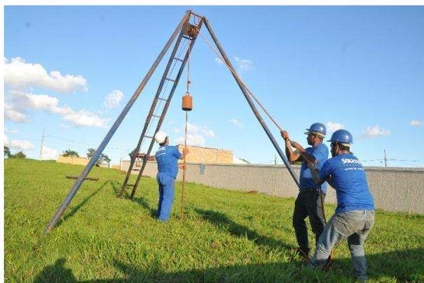
FIGURA 3.4 – Exemplo da execução de uma sondagem SPT. Fonte: (ENGENHARIA, 2024b)
