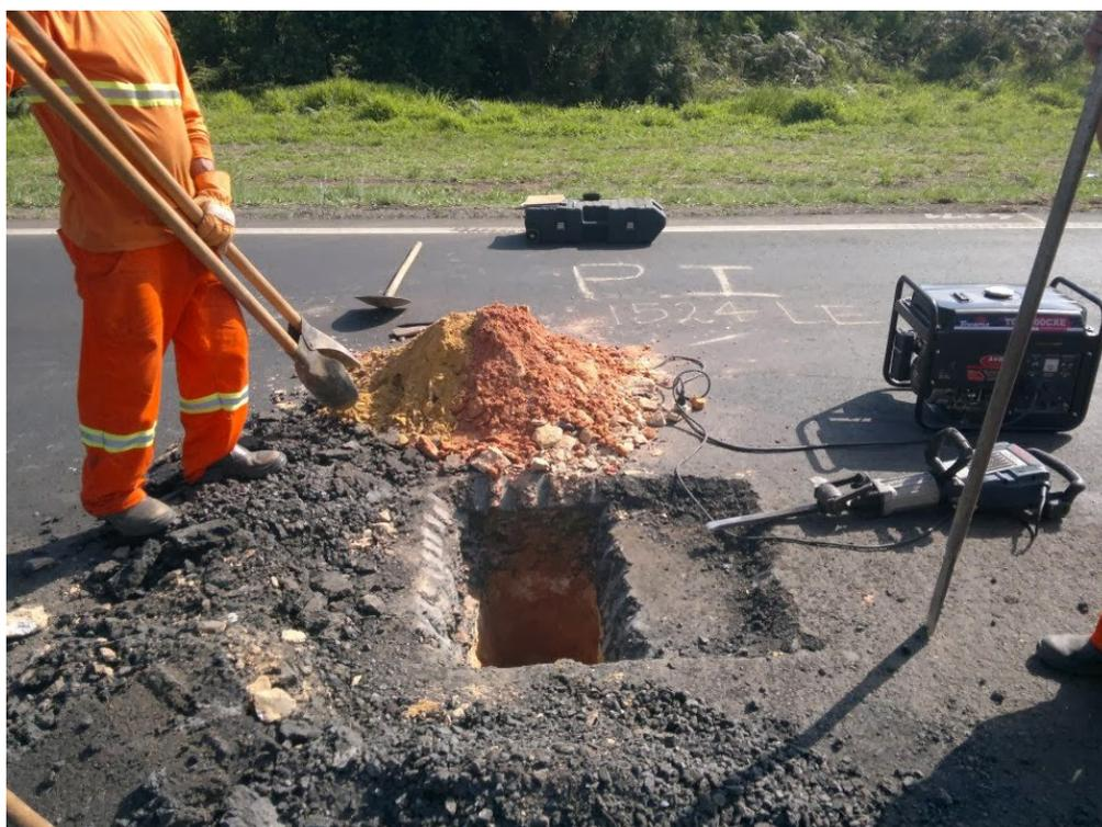
FIGURA 2.1 – Poço de Inspeção realizado em um pavimento flexível (STRATO SONDAgens, 2014).
