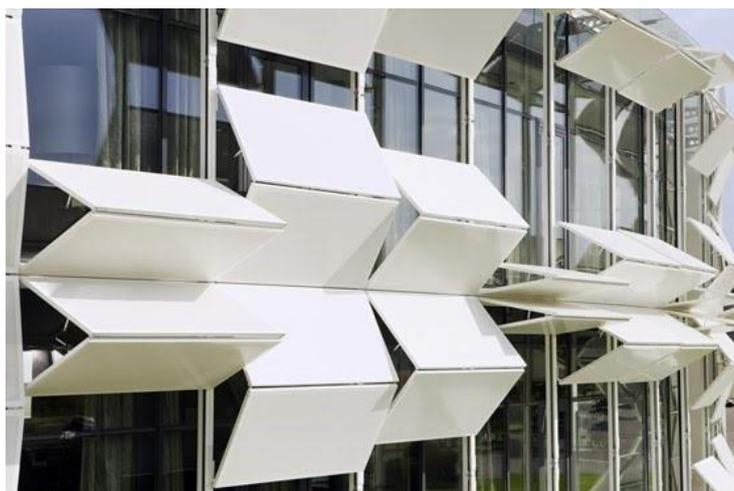
Figura 2.9 – Exemplo de Fachada Dinâmica na Áustria – FIEC (2014)
