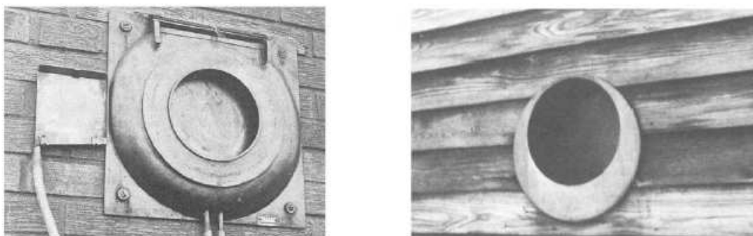
Figura 12 - Coletores com seção circular (BLOCKEN E CARMELIET, 2004)
