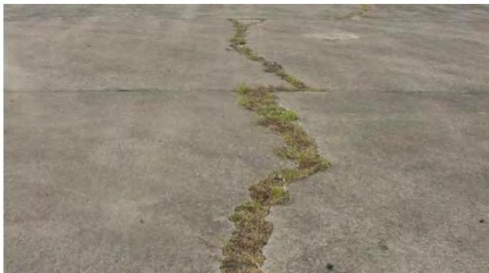
Figura 4.5: Trinca térmica no pavimento rígido da área 2.
