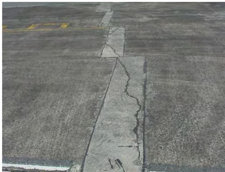
Figura 4.4: Trincas no pavimento rígido da área 1.
