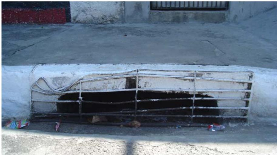
Figura 5.6 – Grade adaptada para prevenção de acidentes em uma boca-de-lobo (foto obtida em campo, dez. 2006).
