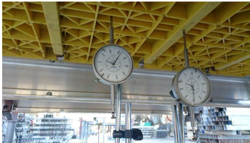
Figura 4: Extensômetros utilizados nos testes de carga.
