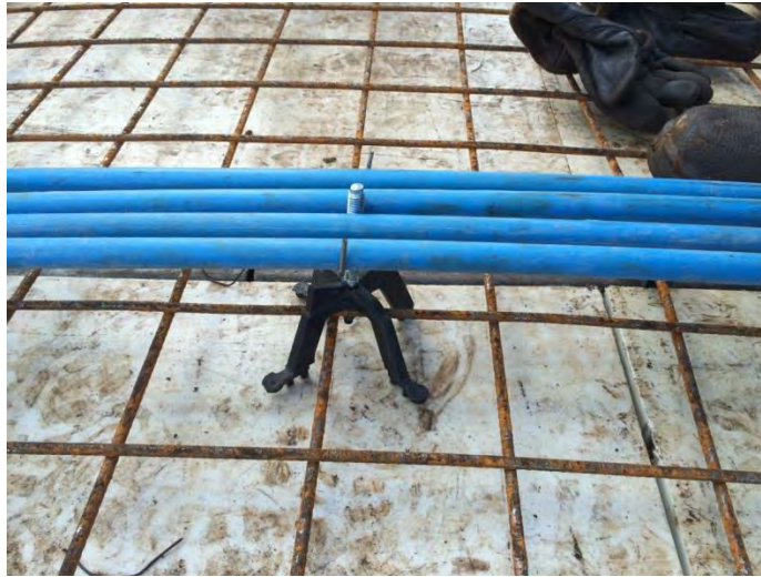
Figura 7b: Protótipo inicial do novo apoio para cordoalhas.
