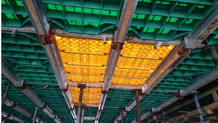
Figura 6: Plasterit 122 (amarelo) sendo utilizado em obra: vista inferior.
