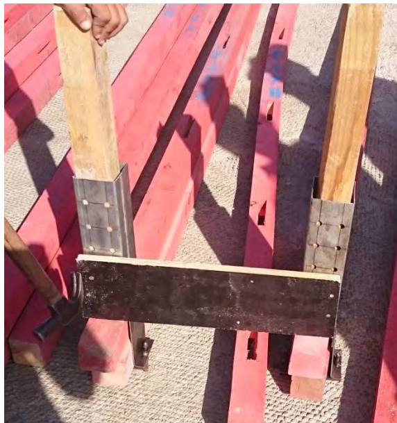
Figura 11: LDB sendo testada com madeira na obra.
