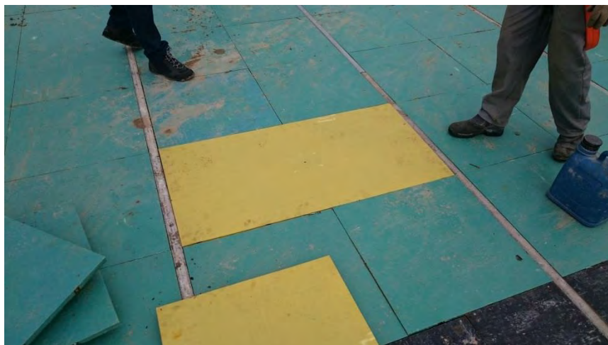
Figura 5: Plasterit 122 (amarelo) sendo utilizado em obra: vista superior.
