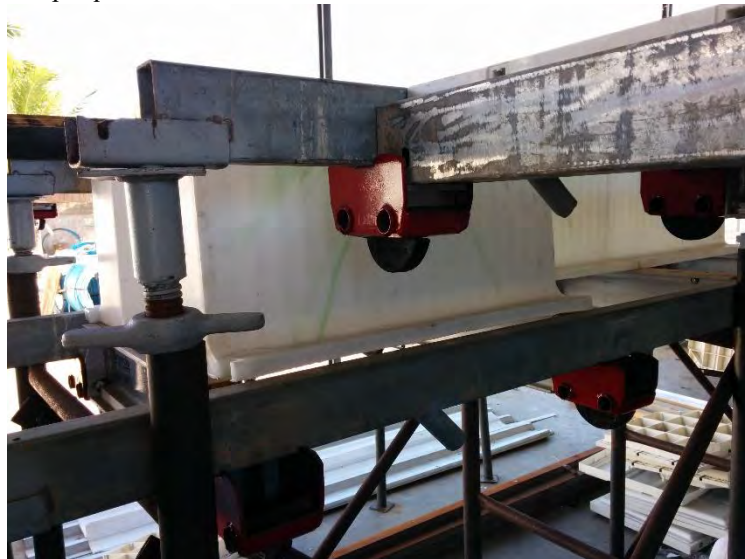
Figura 1: Protótipo do Cimbramento para laje plana.
