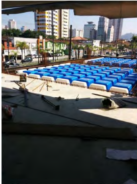
Figura 3: Cubetas de 80 cm x 80 cm sendo utilizadas em obra.
