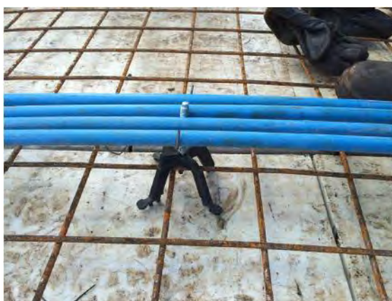
Figura 8: Protótipo do novo apoio sendo utilizado em obra.
