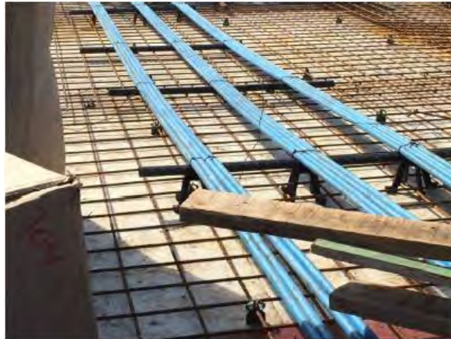
Figura 6: Apoios tradicionalmente usados para cordoalha engraxada.
