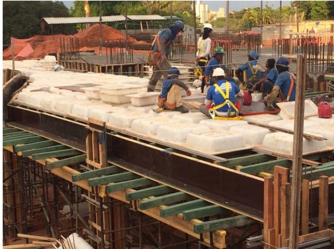
Figura 7 - Montagem das caixas plasterits do 1º pavimento de obra em Limeira.
