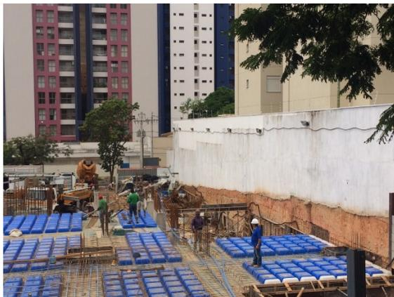
Figura 3 - Concretagem do pavimento térreo de obra acompanhada em Campinas.
