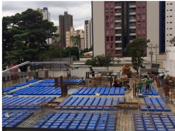
Figura 2 - Concretagem do pavimento térreo de obra acompanhada em Campinas.
