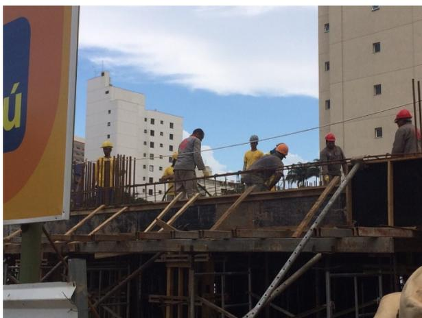
Figura 6 - Montagem das caixas plasterits do 1º pavimento de obra em Limeira.
