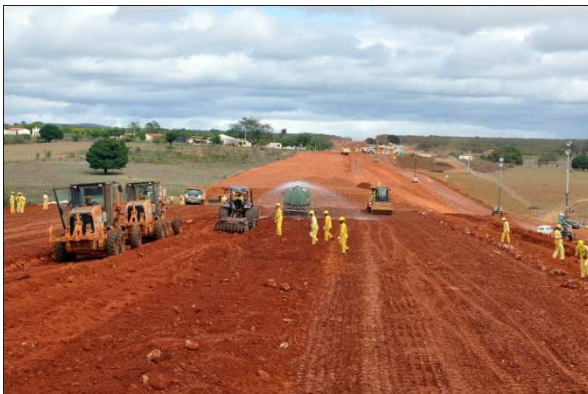
Figura 4 – Execução de aterro e corte em rocha
