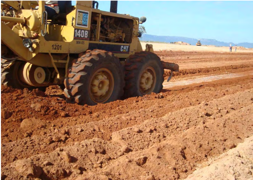
Figura 4 - Acompanhamento da Compactação das Camadas da Pista
