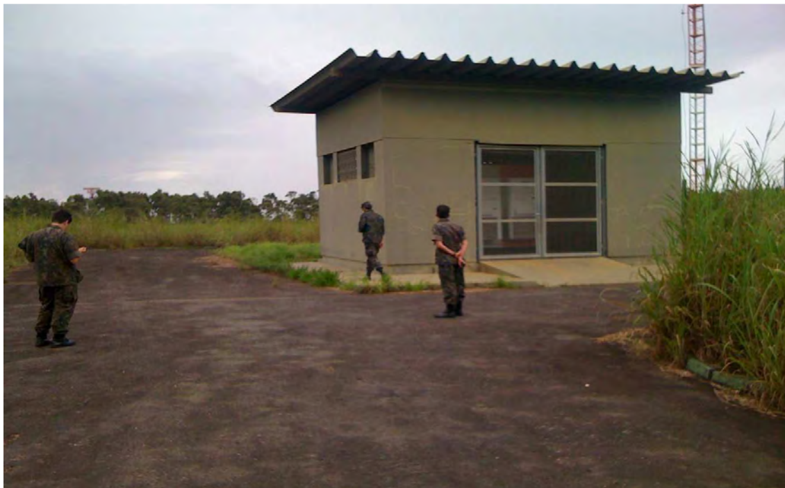
Figura 3 - Estruturas Irregulares na Área da Pista
