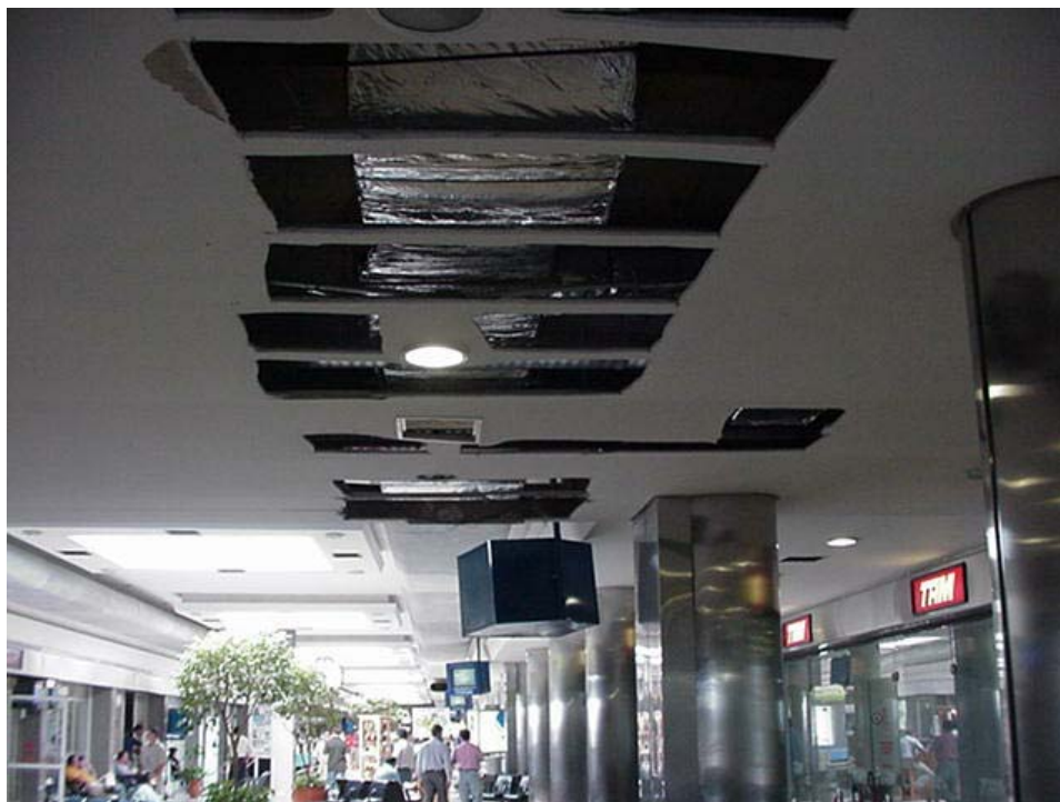
Figura 1: Instalação dos tubos de Climatização
