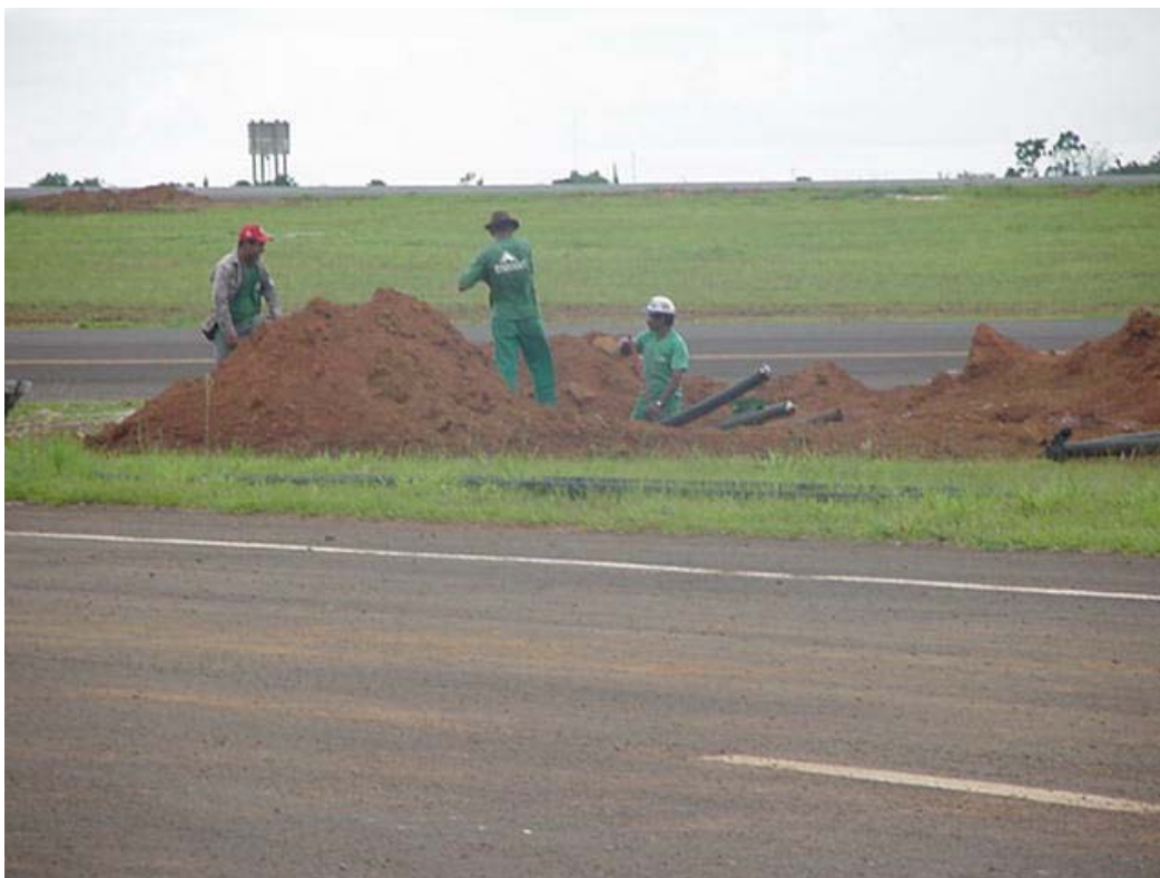
Figura 3: Cabeamento do Balizamento
