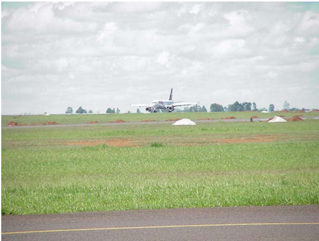
Figura 10: Obras nas laterais da pista
