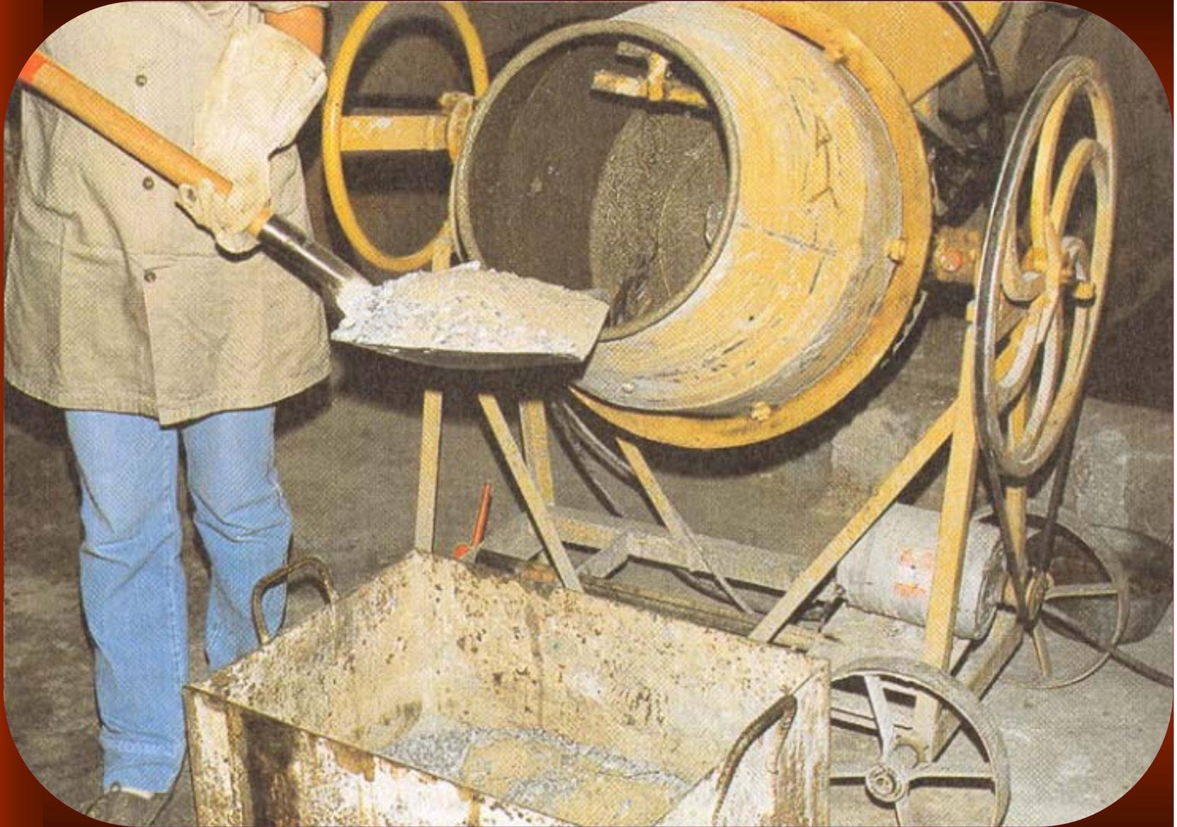
Lançamento dos agregados na betoneira
