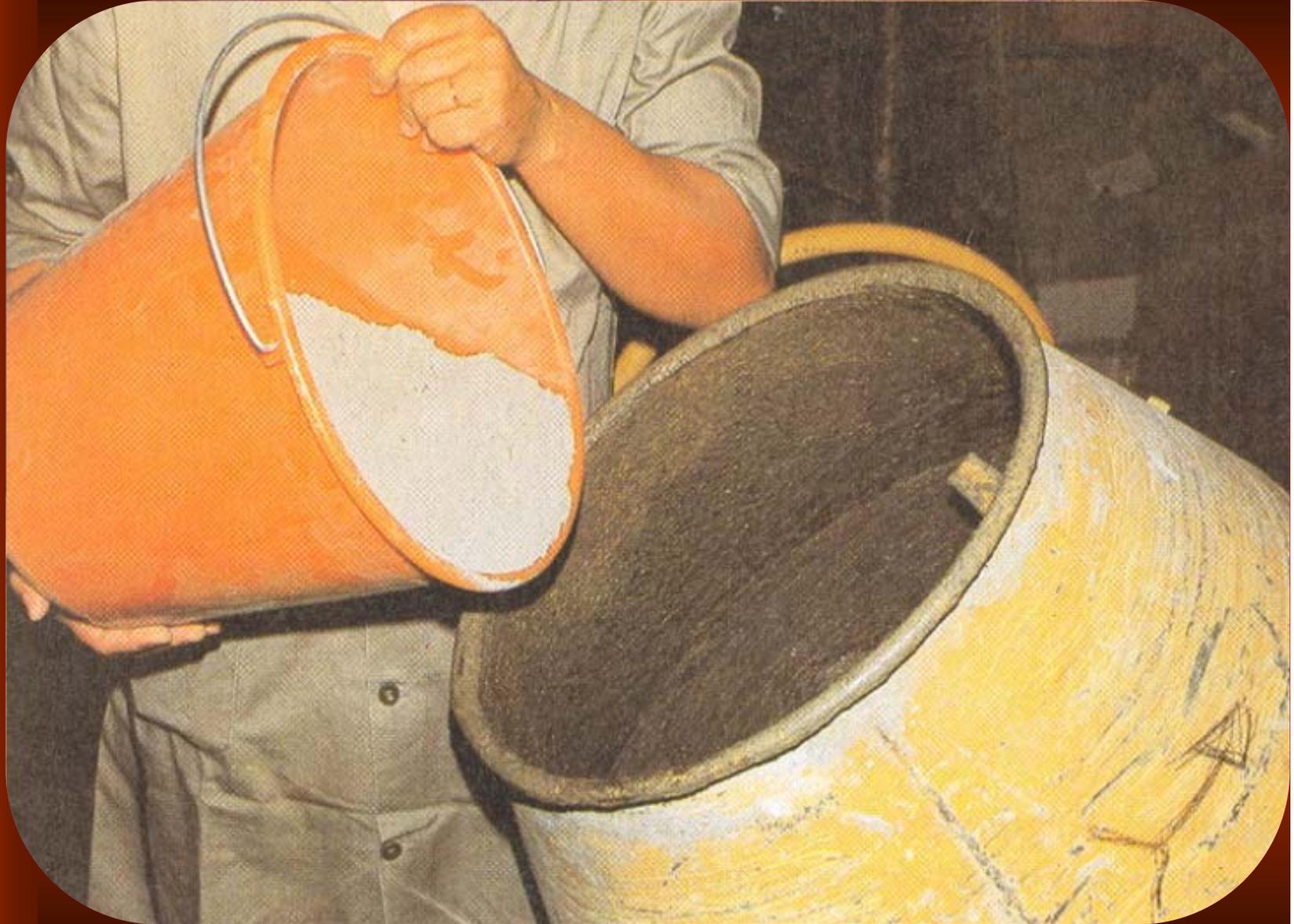
Após homogeneização de agregados com pouca água, adição do cimento
