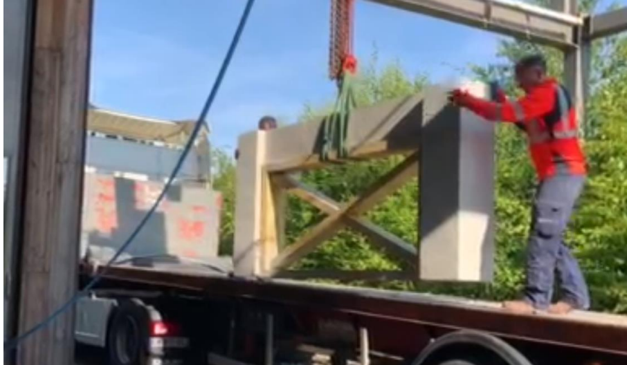
Figure 21 : Livraison des portiques au Laboratoire Navier
