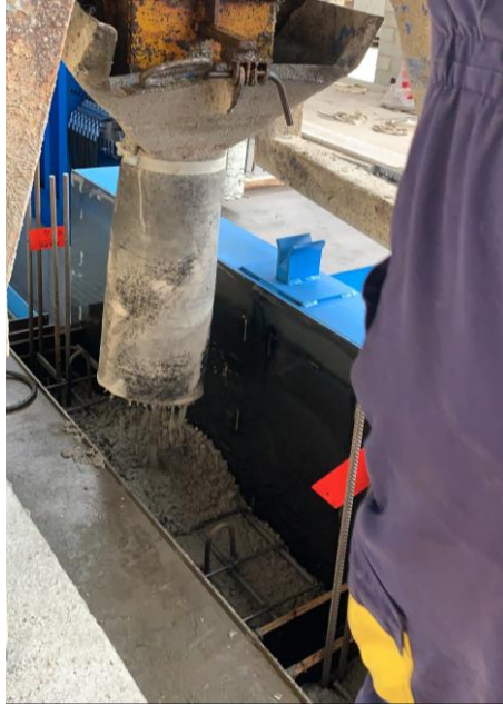
Figure 18 : Coulage des poutres
