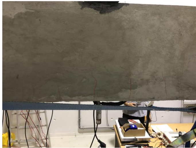
Figure 24 : Zone de fissuration à mi-travée
