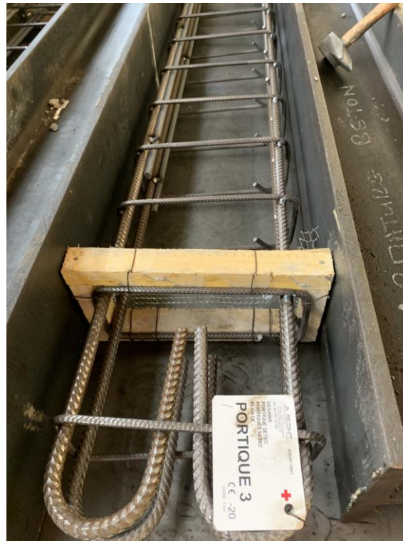
Figure 17 : Ferrailage du portique 3 zones de clavetage en C60
