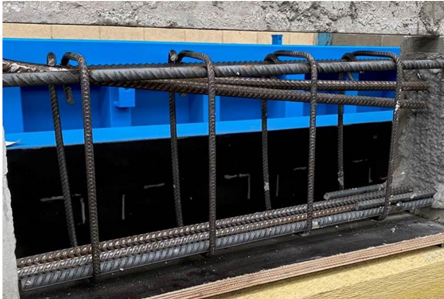
Figure 20 : Ferrailage de la zone de clavetage en C60
