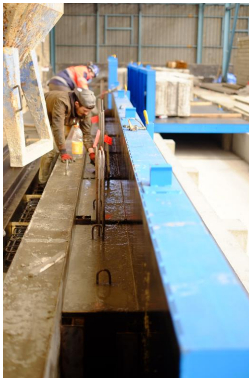
Figure 19 : Eléments des poutres après finition.
