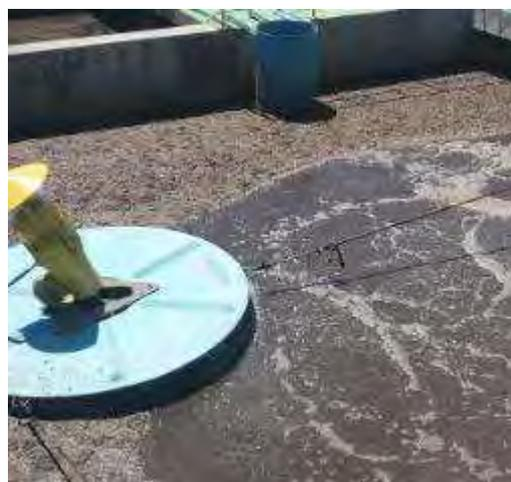
Figura 11 – Tanque de aeração com aerador superficial ETE Atacado CA
