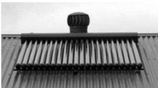
Figura 4. Coletor solar de tubos a vácuo (ENIVRO-FRIENDLY, 2005, apud SLEMAN, 2006)
