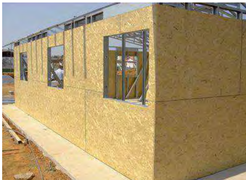
Figura 8: Instalação de placas OSB
