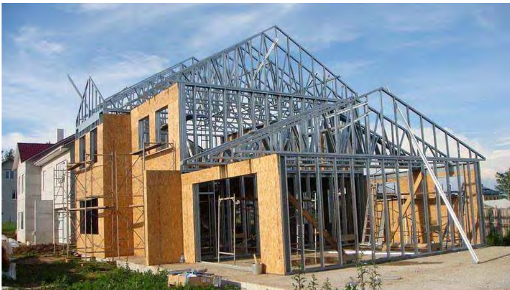
Figura 2: Estrutura construída em Light Steel Frame
