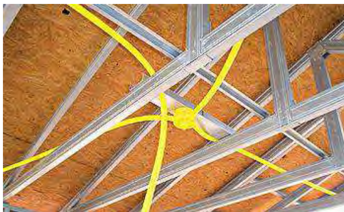
Figura 9: Passagem de instalação elétrico em obra de LSF
