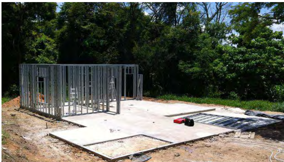
Figura 7: Fundação finalizada de uma obra em LSF
