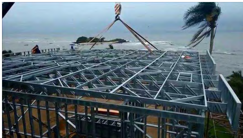
Figura 10: Cobertura realizada em LSF
