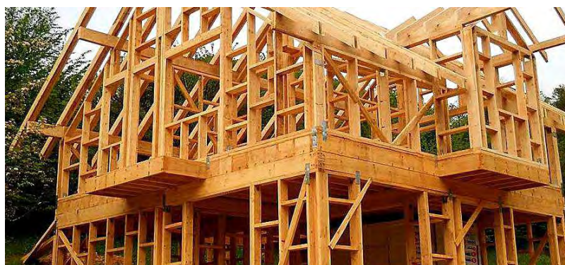
Figura 1: Estrutura construída em Wood Frame
