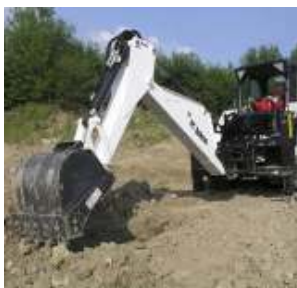
Figura 18 – Minicarregadeira com implemento de retroescavadeira.
