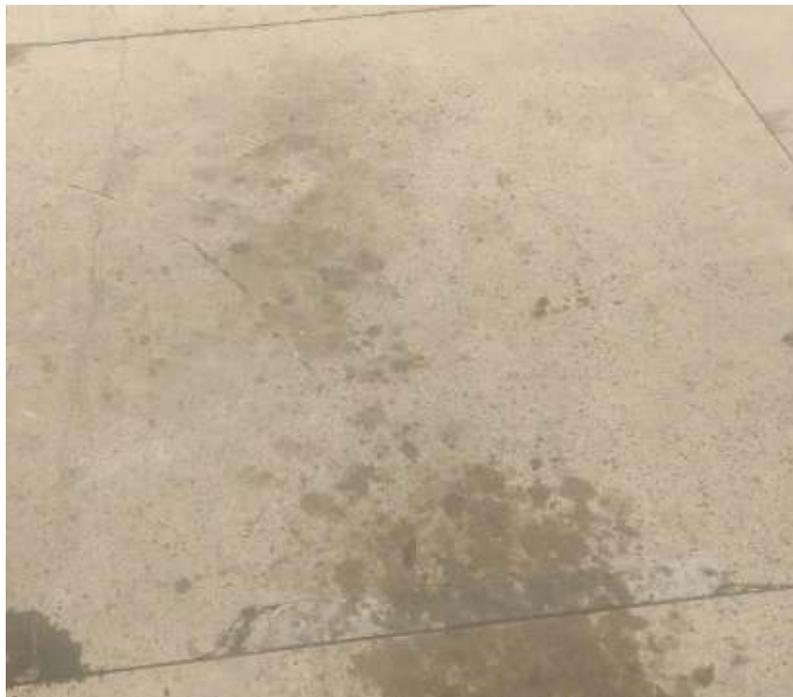
Figura 1.1 – Pavimento de concreto contaminado com óleo do Aeroporto de São Paulo/Congonhas (CGH).
