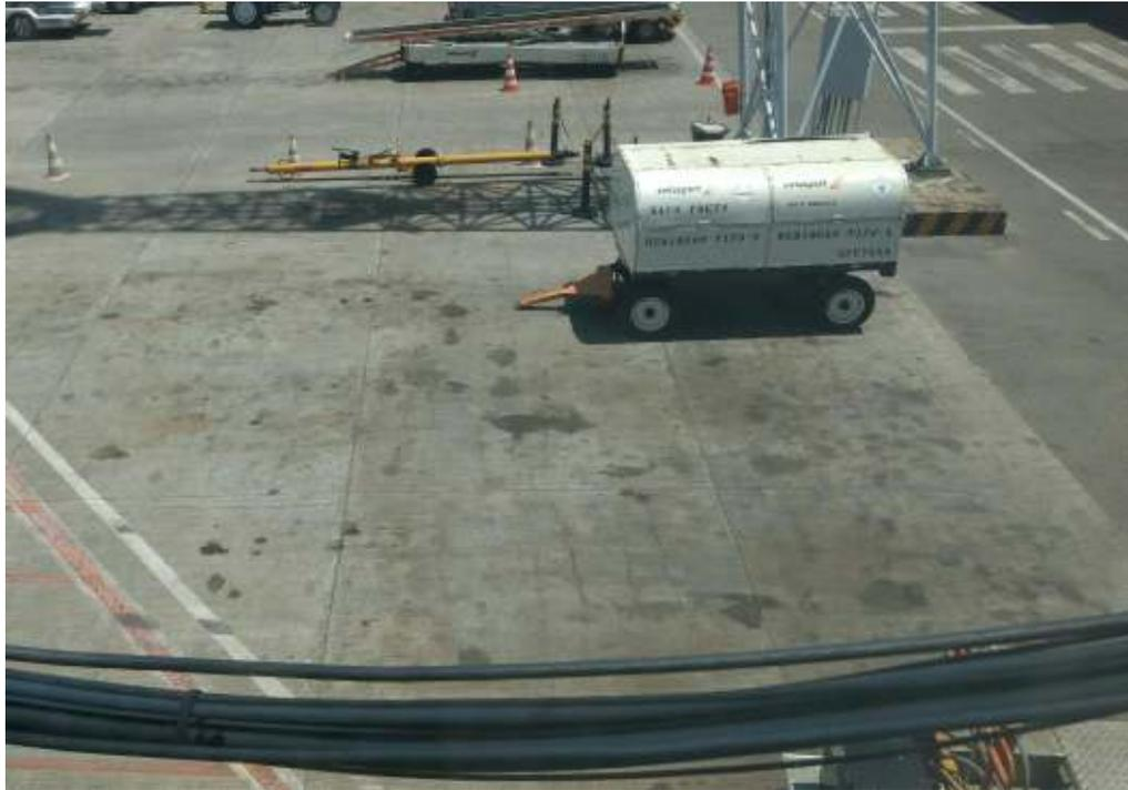
Figura 1.2 – Pavimento de concreto contaminado com óleo do Aeroporto de Recife (REC).
