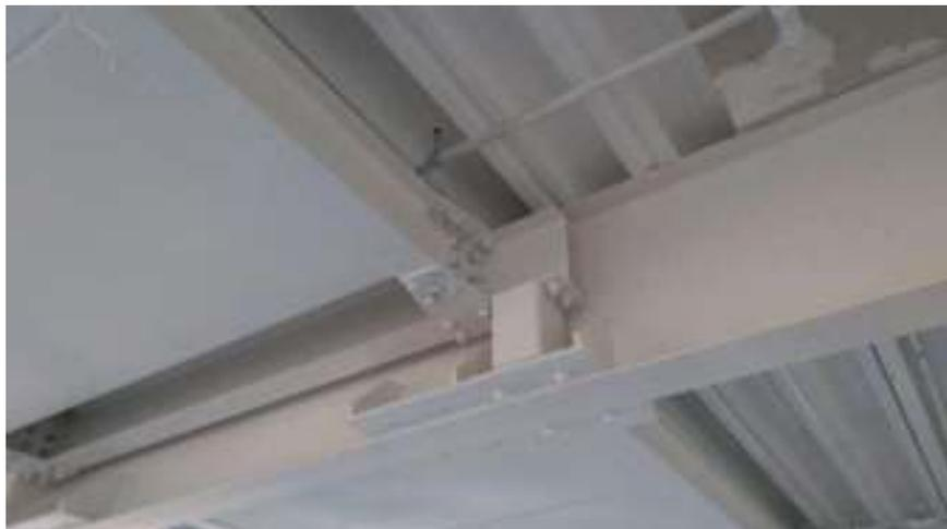
**Figura 1.2** Posição de encaixe dos isoamortecedores.
