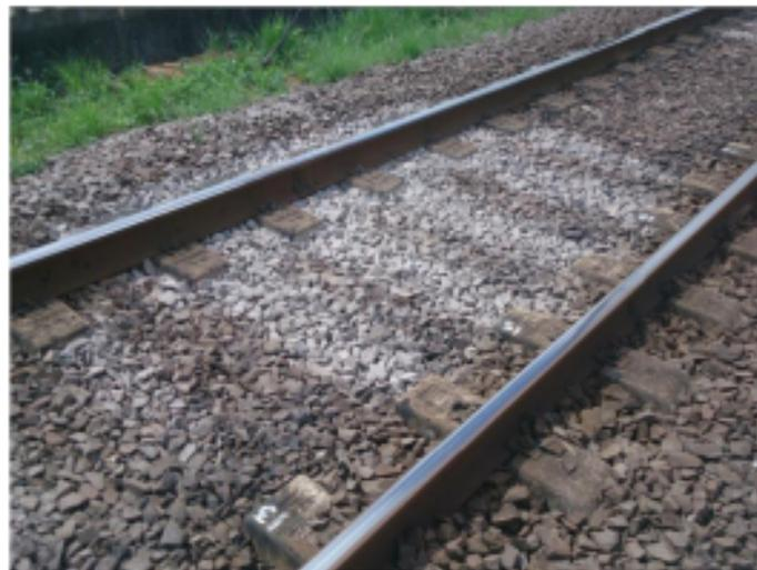
FIGURA 4.11 - Lastro Contaminado (SILVA, RAMIRES, et al., 2015).
