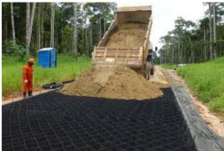
FIGURA 3.24 - Instalação de Geocélulas em Coari/AM (Comitê Técnico de Geossintéticos).
