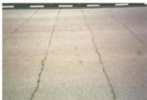
FIGURA 2.10 - Trincas de Reflexão na Superfície (CORREIA, PORTELINHA, et al., 2013).
