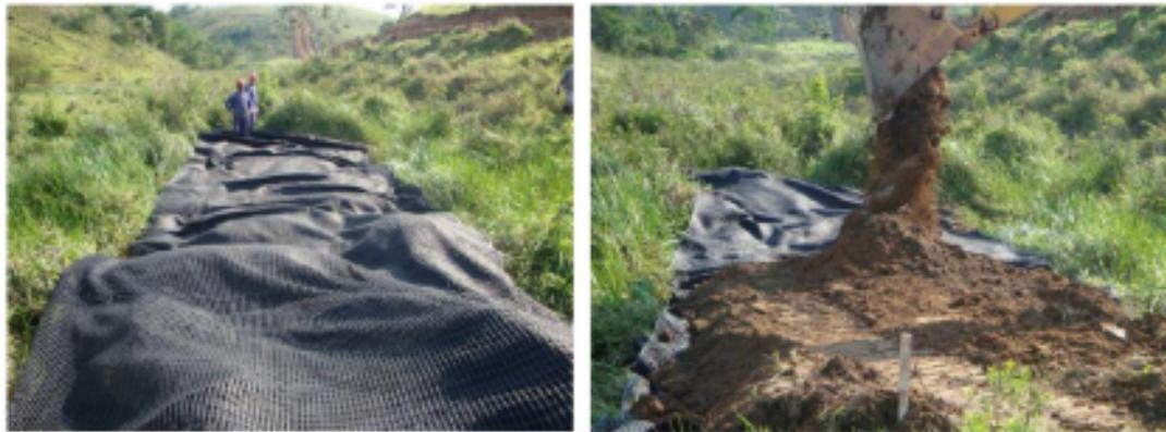
FIGURA 3.21 - Instalação do Reforço e Lançamento do Material (FERRETI, LIMA e SANTOS JÚNIOR, 2012).
