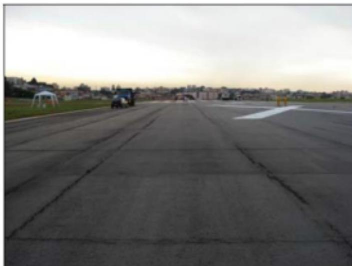
FIGURA 2.5 - Reflexão das Juntas na Capa Asfáltica no Aeroporto de Congonhas (RUIZ, PANDOLPHO, et al., 2015).
