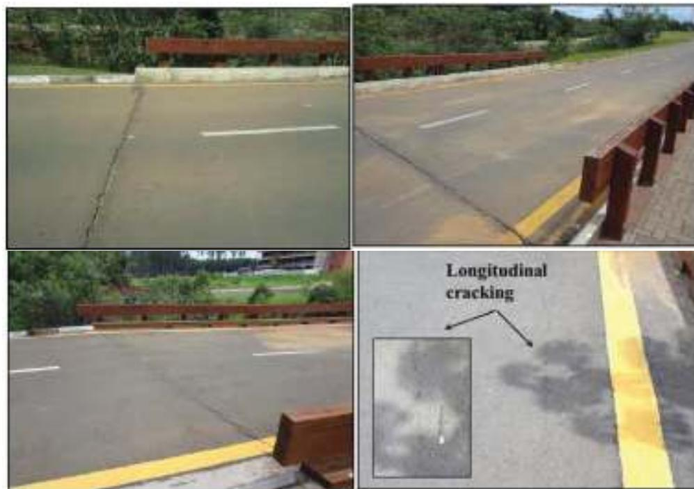
FIGURA 2.11 - Análise Visual das Pontes Não-Reforçadas Após Seis Anos (CORREIA, PORTELINHA, et al., 2013).
