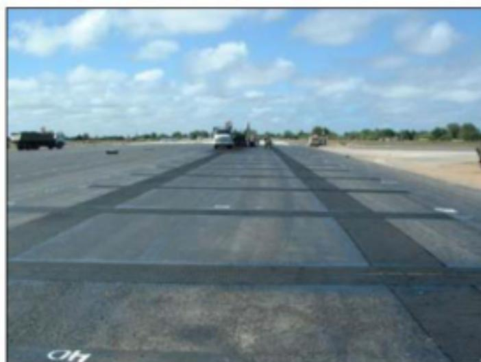
FIGURA 2.6 - Instalação da Geogrelha no Aeroporto de Carrasco (MONTESTRUQUE, RUIZ e CARMO, 2014).
