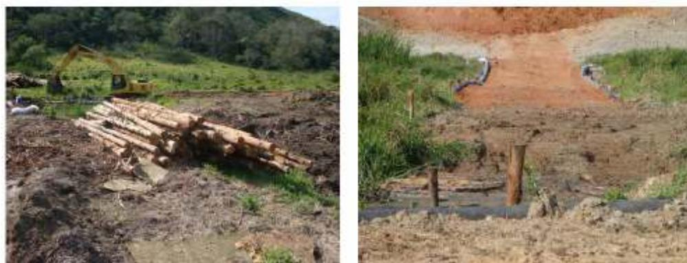
FIGURA 3.19 - Toras de Eucalipto a Serem Utilizadas no Reforço (FERRETI, LIMA e SANTOS JÚNIOR, 2012).
