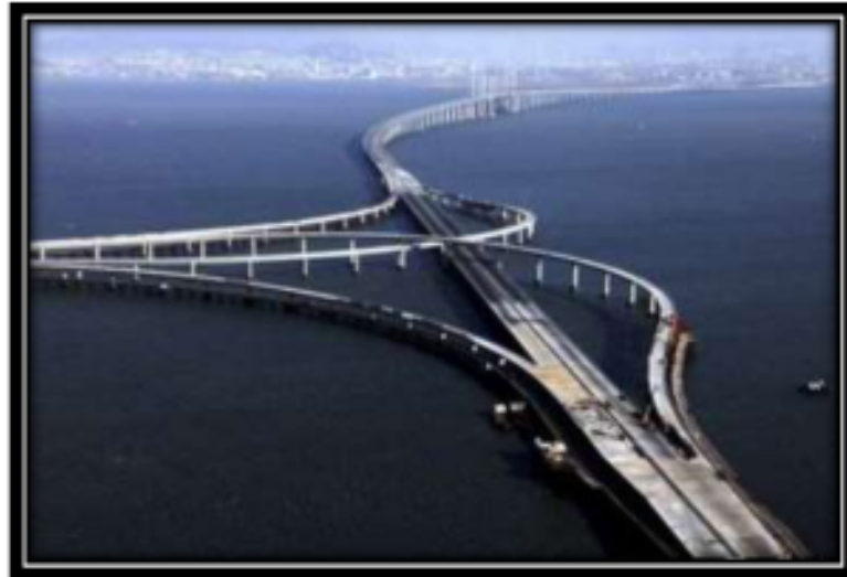
Figura 3 - Ponte Qingdao Jiaozhou Bay. Fonte: HSI Incorporadora (2017) [74]
