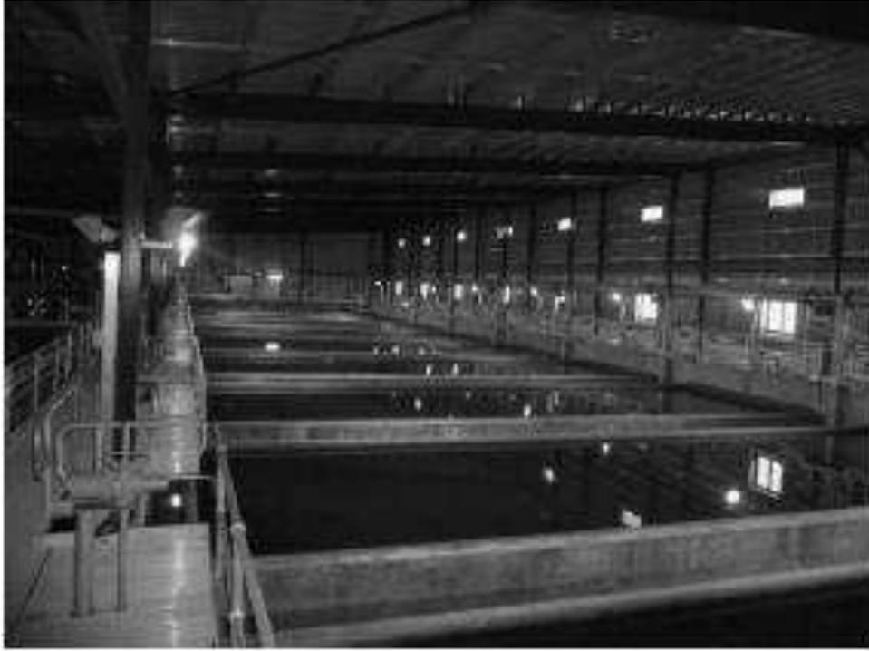
Figura 35: Filtros diretos a gravidade na planta de dessalinização de Gold Coast, Austrália.
