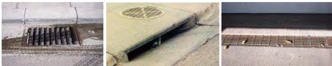
Figura 14 – Tipos de boca-de-lobo na cidade de Aspen (EUA). Da esquerda para a direita: grelha, abertura na guia e entrada linear. Retirado do City of Aspen Urban Runoff Management Plan (2011)
