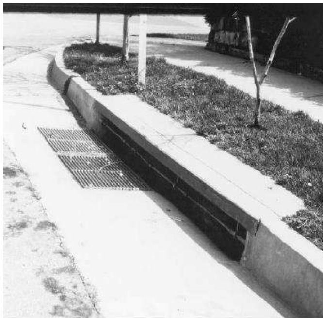
Figura 22 – Exemplo para o caso do aparelho combinado retirado do City of Aspen Urban Runoff Management Plan (2011)
