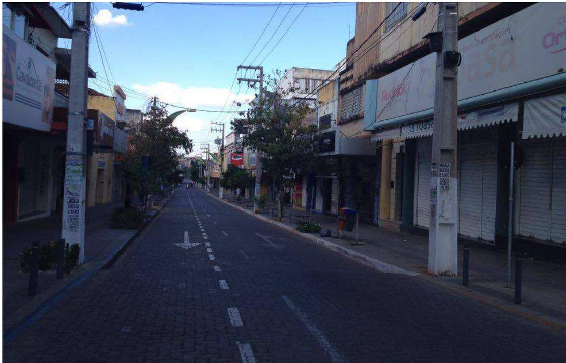
Figura 50: Centro de Crato, após revitalização, com ambiente urbano mais adequado, com calçadas alargadas, presença de bancos, canteiros e lixeiras, nova pavimentação das ruas e travessias elevadas para pedestres. (Fonte: Autor)
