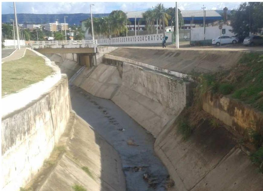
Figura 23: Transição entre o trecho reconstruído, superior, e não reconstruído, inferior, do canal do rio Granjeiro, mostrando estreitamento do leito. (Fonte: SÁ, 2015)
