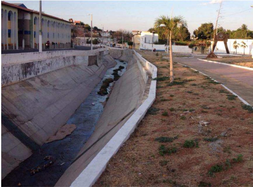
Figura 22: Trecho intermediário, reconstruído, do canal do rio Granjeiro, ilustrando seções transversais com diferentes dimensões. (Fonte: Autor)
