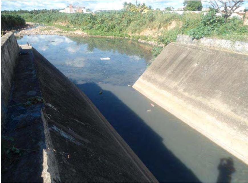
Figura 20: Seção a jusante, não reconstruída, canal do rio Granjeiro.
