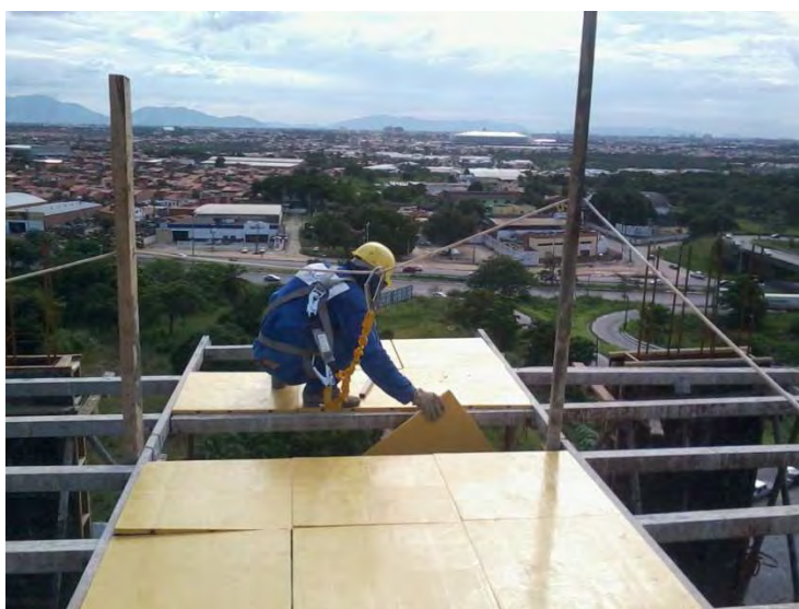
Figura 8 Necessidade de maior segurança (fonte: Impacto, 2014).
