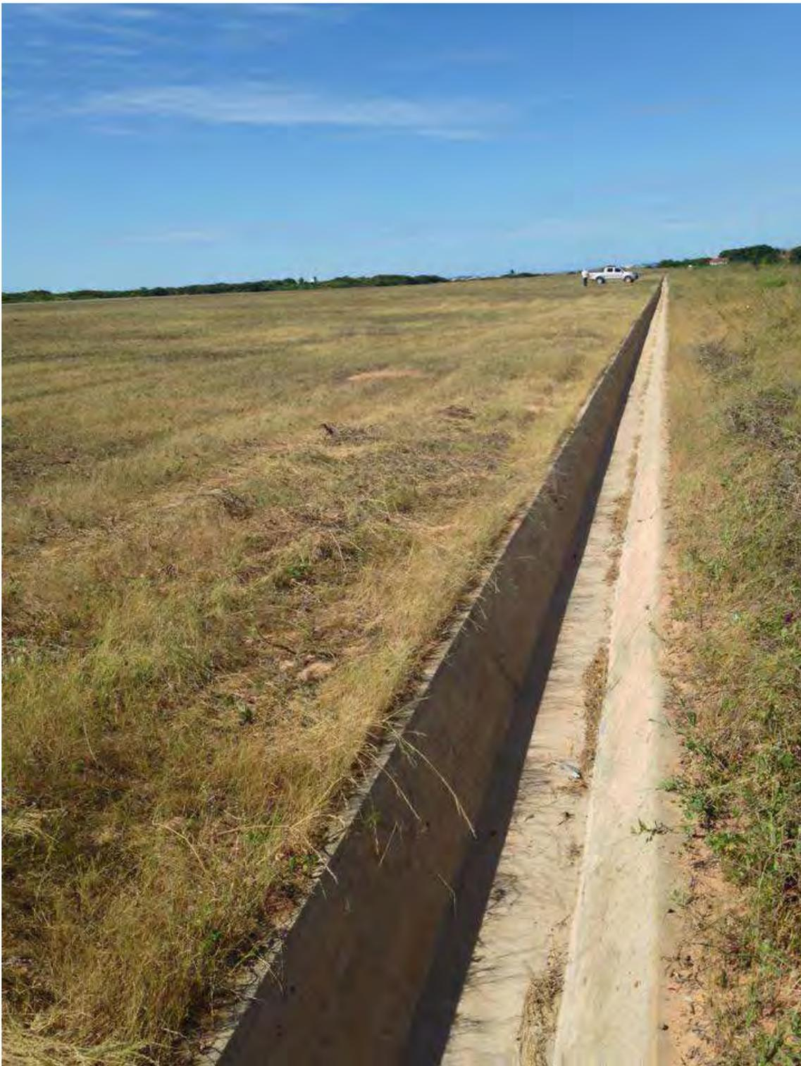
**Figura 13: Canaleta superficial, longitudinal à pista de pouso. (ROCHA ENGENHARIA)**
