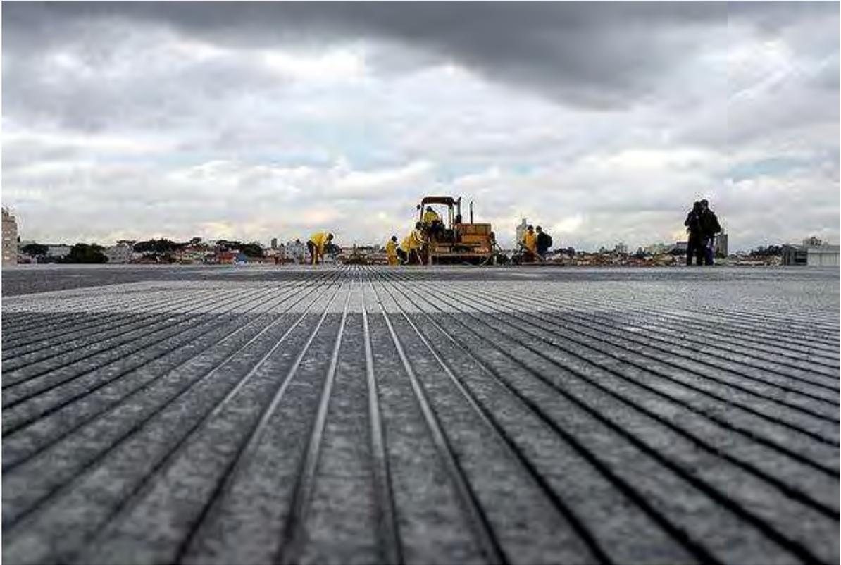
**Figura 6: Grooving sendo aplicado à pista do Aeroporto de Congonhas no dia 25 de julho de 2007, após o acidente.**
