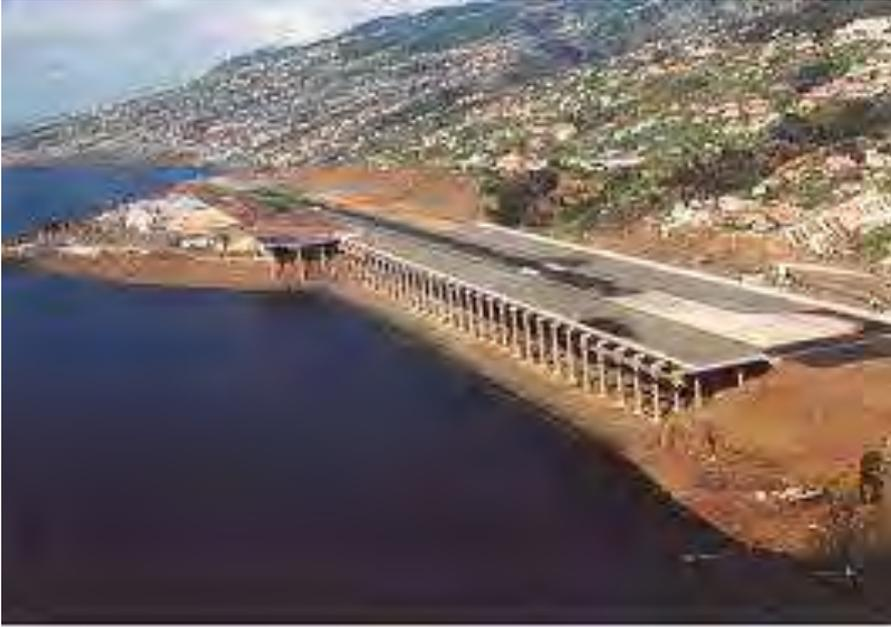
**Figura 26: Pista sobre pilotis no Aeroporto de Funchal, na Ilha da Madeira, Portugal.**
