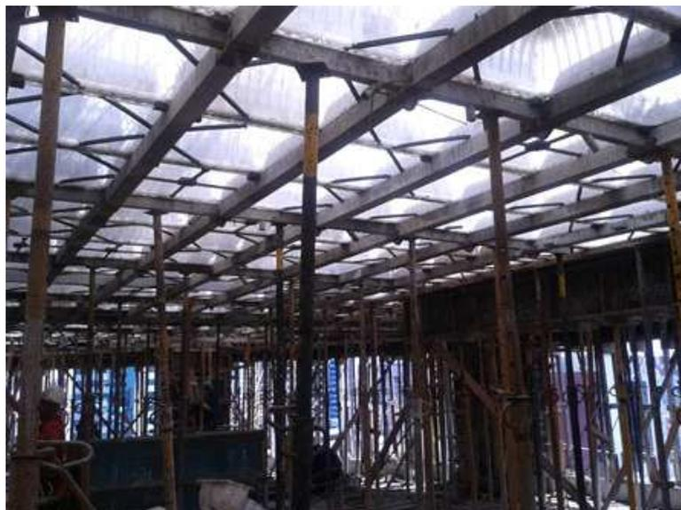
**Figura 4.1** Sistema CIMP montado (fonte: Impacto, 2013).
