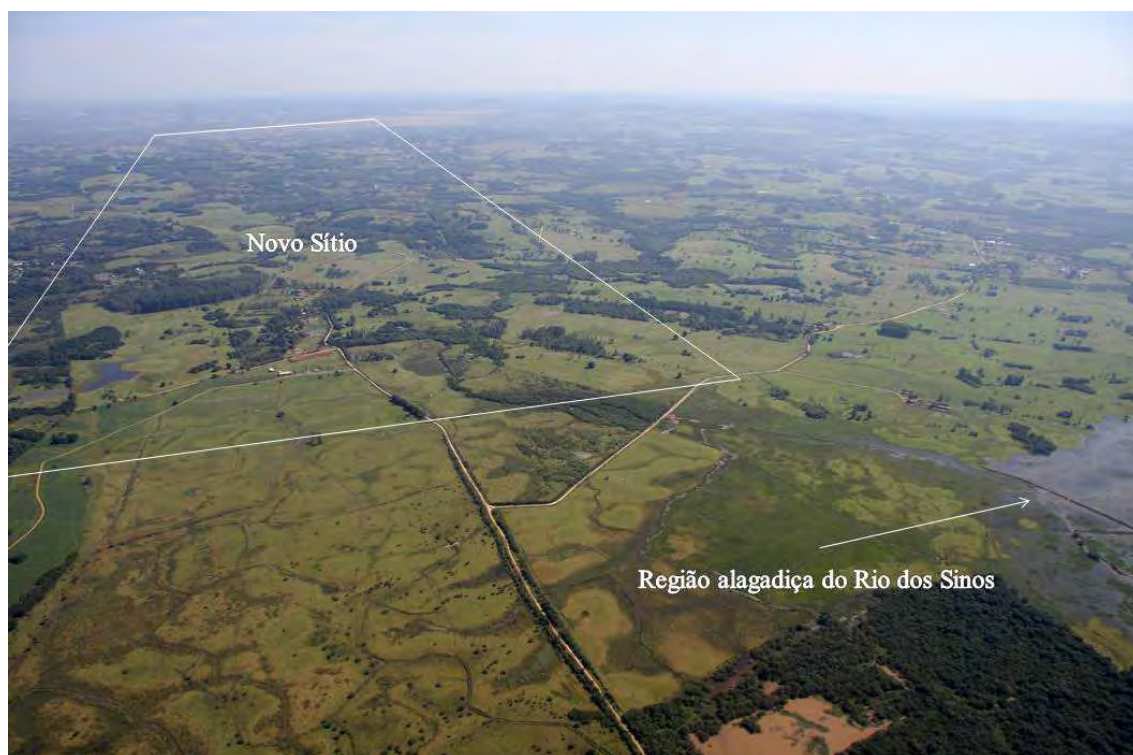
Figura F5 – Foto aérea evidenciando a região alagadiça próxima ao Rio dos Sinos
