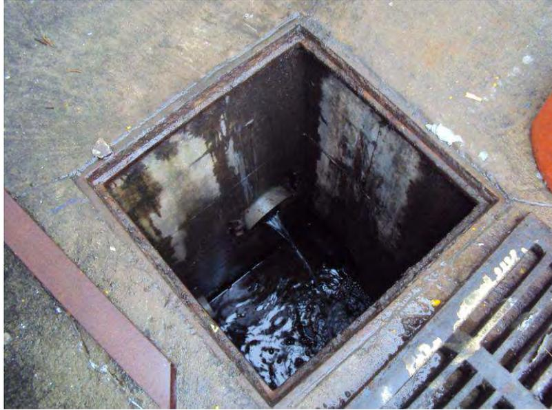
**Figura 14 – Caixa de areia à jusante de um dos condutores verticais do H 003**
