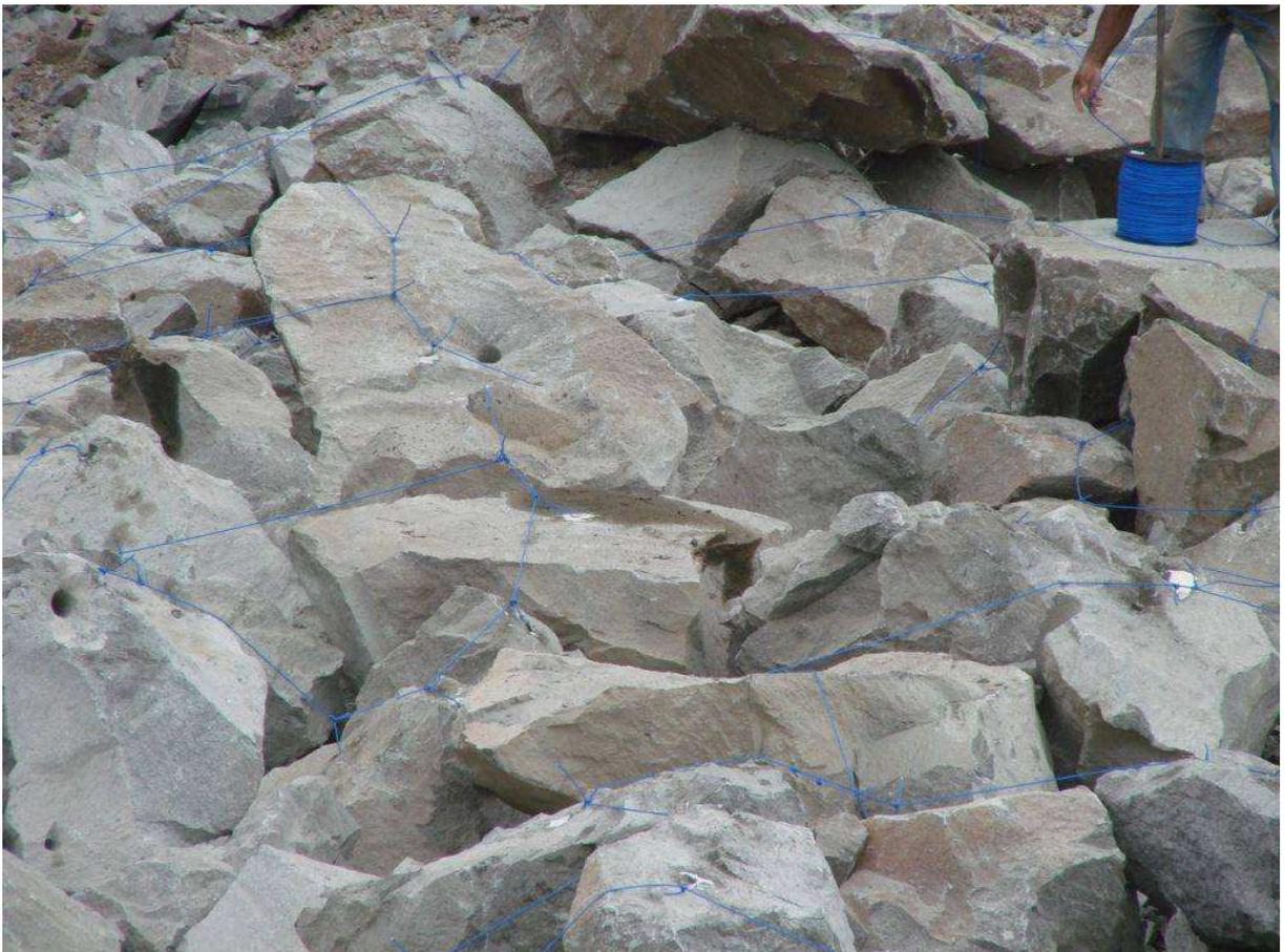
*Figura 3: Etapa de instalação do cordel detonante do fogacho.*
