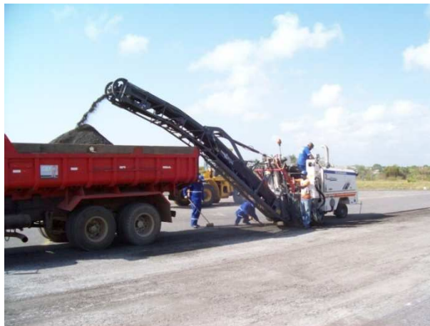
Figura 8. Execução de fresagem no Aeroporto de Manaus-AM
