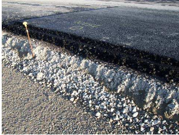
Figura 7. Execução de Sandwich Pavement
