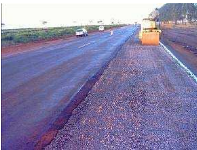
Figura 9. Execução de obra com TSD
