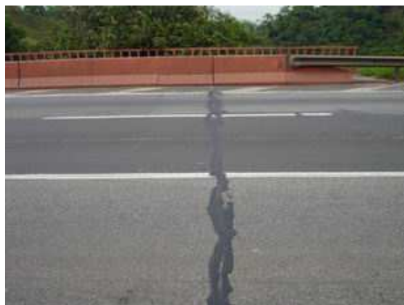
Figura 6. Foto de revestimento após selagem
