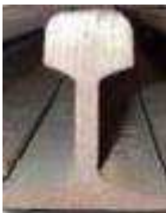
Figura 2.6 Perfil do trilho tipo Vignole. [12]
