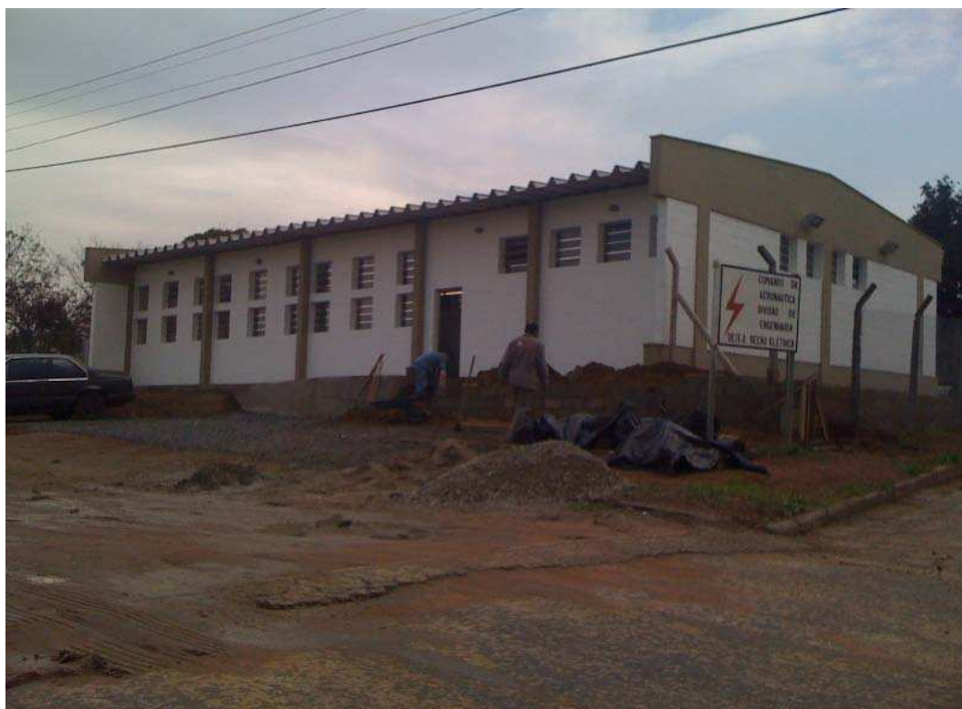
Figura 2 - Galpão de materiais elétricos em estágio de finalização da obra
