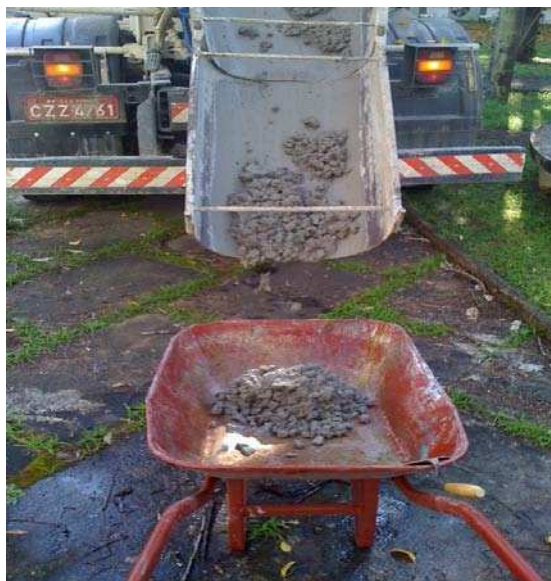
Figura 8 – Chegada de concreto para moldagem.
