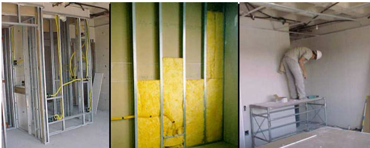
Figura 9: Colocação do dry-wall em uma obra.
