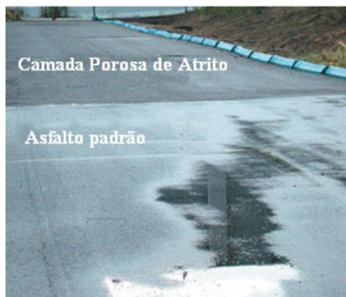
Figura 6.3 – Comparação da capacidade de dreno dos dois tipos de asfalto
