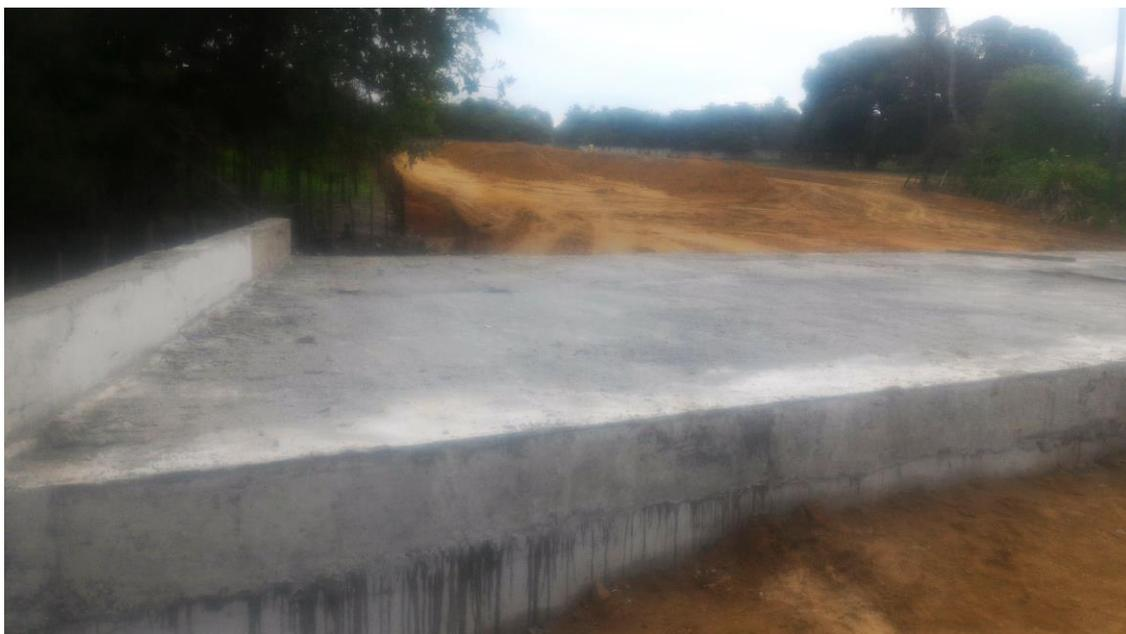
**Figura 5 - Bueiro celular triplo finalizado e depósito de terra para serviço de aterro ao fundo da foto**
