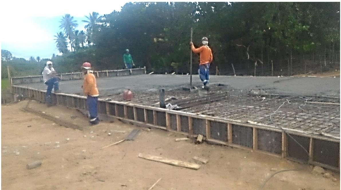
**Figura 4 - Concretagem de bueiro celular triplo**
