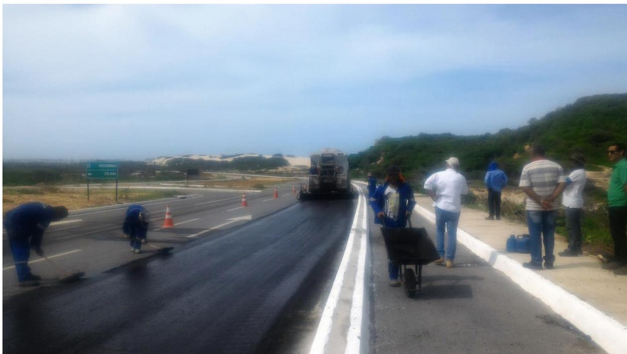
**Figura 6 - Execução de micro revestimento para corrigir imperfeições na pista**
