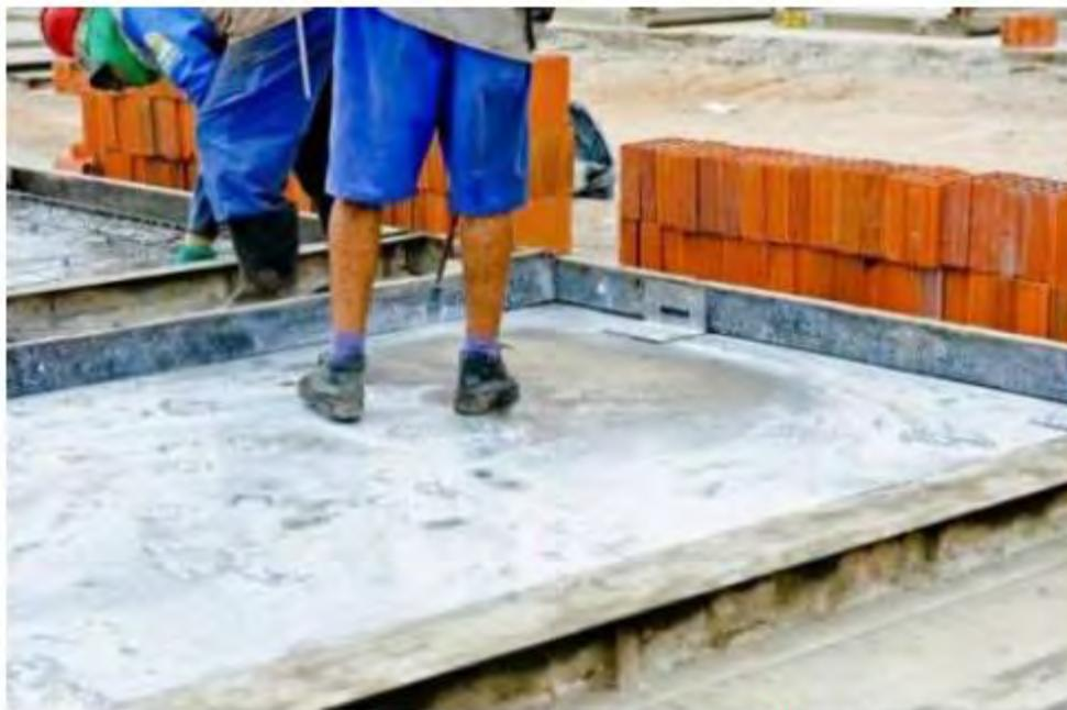
Figura 4 – Aplicação do desmoldante.
