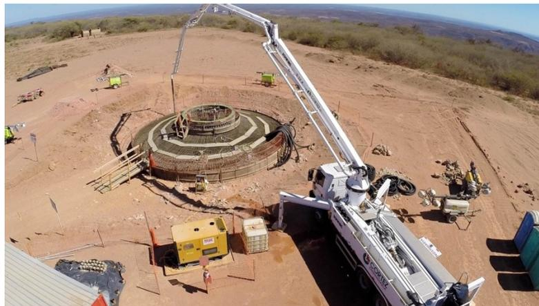
Figura 2: Concretagem da base de torre eólica. (Fonte: Cortez Engenharia)
