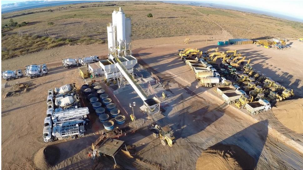
Figura 1: Usina de concreto e diversos equipamentos utilizados na obra de parque eólico. (Fonte: Cortez Engenharia)
