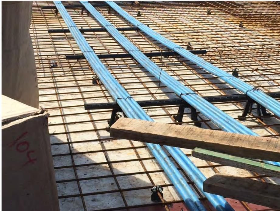
**Figura 6: Apoio atual para as cordoalhas. Pouco eficiente.**
