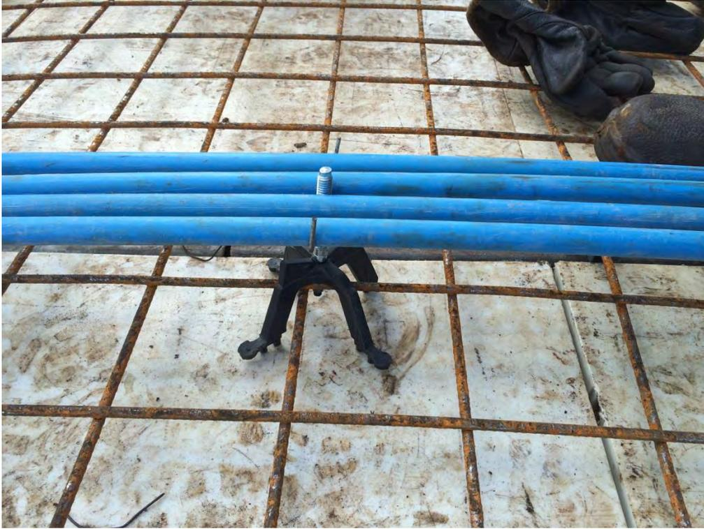
**Figura 7: Protótipo inicial do novo apoio para cordoalhas.**
