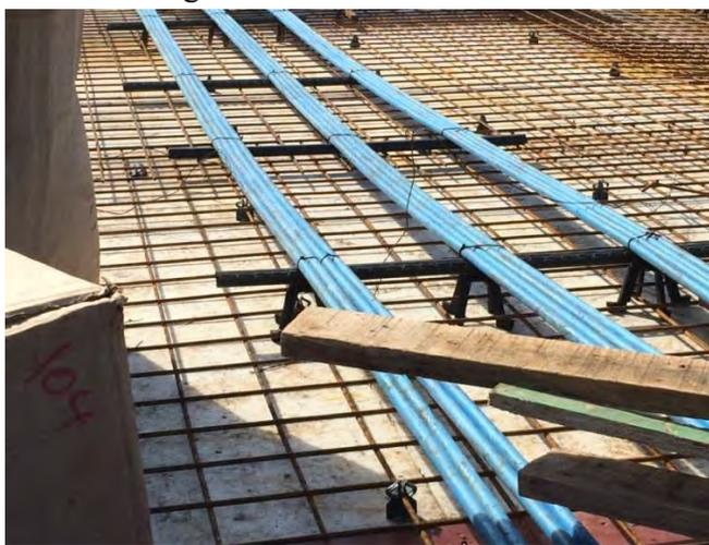
**Figura 7a: Apoio atual para as cordoalhas: pouco eficiente.**
