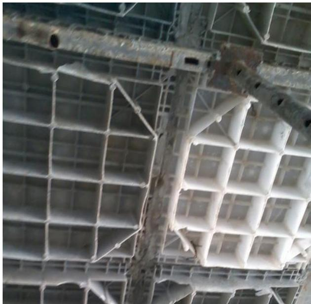
**Figura 7** Vazamento de concreto entre as juntas do *Plasterits* (fonte: Impacto, 2014).
