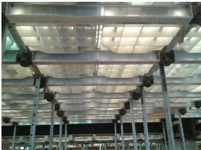
**Figura 3** Vista inferior dos *Plasterits* sobre o CIMP.
