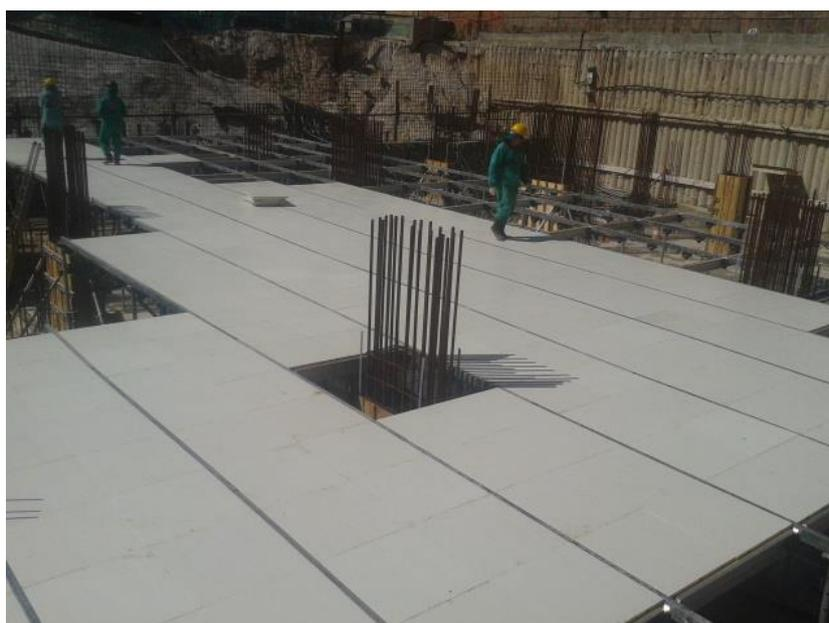
**Figura 4** Vista superior dos *Plasterits* sobre o CIMP.
