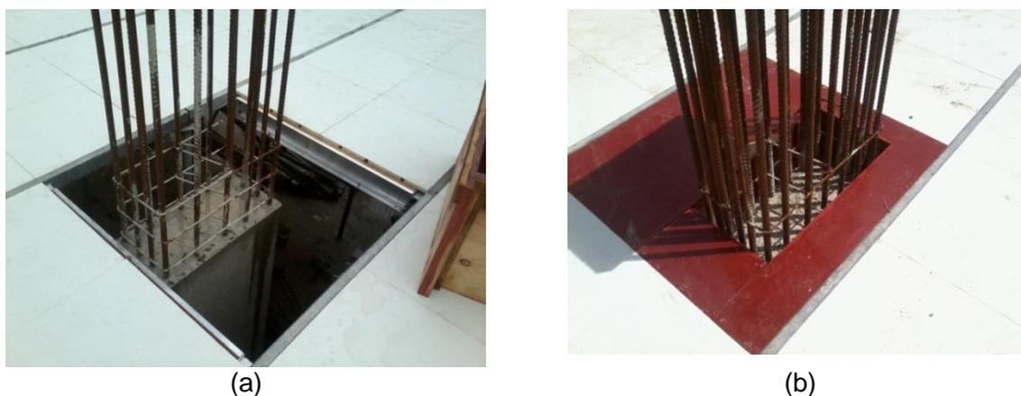
**Figura 5** (a) Necessidade de madeira para completar acabamento em torno dos pilares; (b) Compensado de madeira para acabamento em torno dos pilares (fonte: Impacto, 2014).
