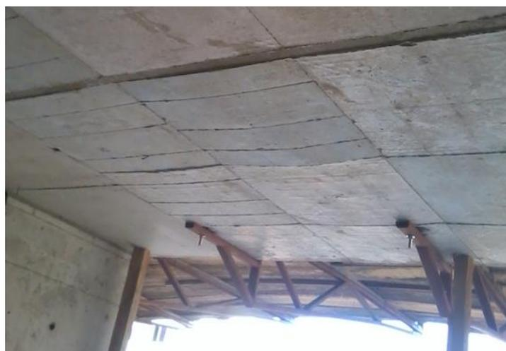
**Figura 6** Flecha excessiva da laje (fonte: Impacto, 2014).
