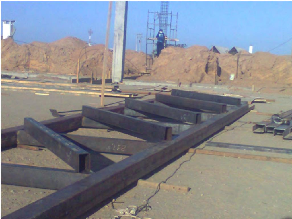
**Figura 4.** Confeção de vigas metálicas
