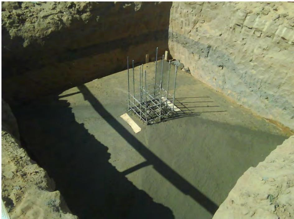
**Figura 2.** Sapata em processo de concretagem e arranques para concretagem do pilar
