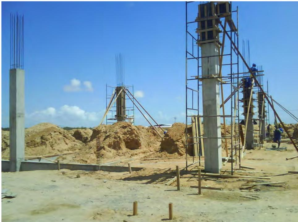
**Figura 3.** Concretagem dos pilares
