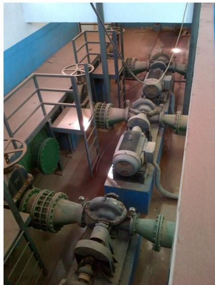
**Figura 4:** Detalhes dos 3 atuais conjuntos motobombas da estação elevatória de água tratada de Mauá.
