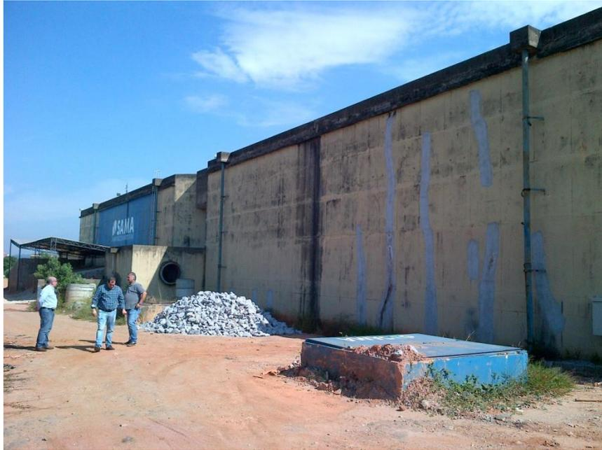
**Figura 3:** Parede externa do Reservatório Mauá (30000 m<sup>3</sup> de capacidade) e reparos recentes.
