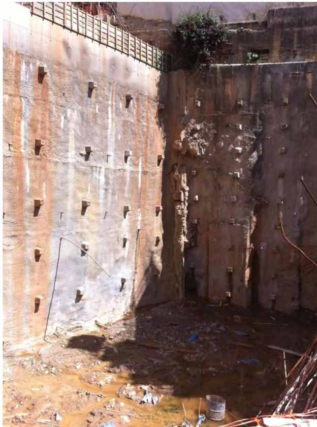
Foto 7 – Parede de contenção reconstruída
