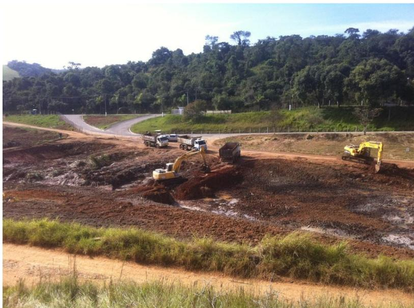
Figura 3 - Obra de Terraplenagem e Drenagem - Retirada de Solo Mole
