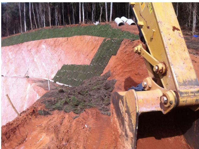
Figura 4 - Obra de Terraplenagem e Drenagem - Acabamento dos Taludes
